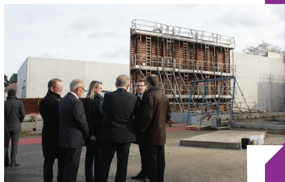
Visite du chantier du Pôle d'Excellence Rural avec les élus du Pays Noyonnais et le Préfet de l'Oise, en présence de l'architecte
