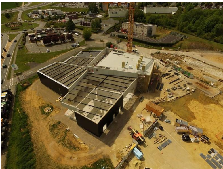
Figure 4. Photographie du Cinéma Le Paradiso en mai 2017, durant les travaux
