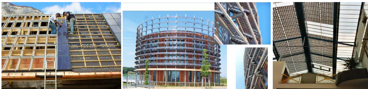
Figure 10. Photos de support de panneaux photovoltaïques 15
