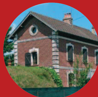
L'ancienne gare de Muirancourt
