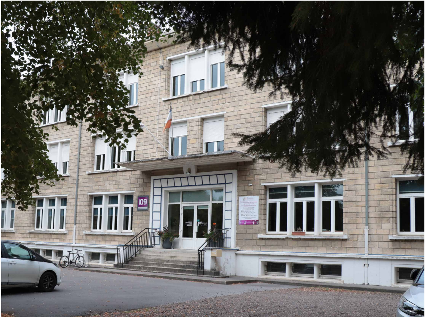
Siège administratif de la Communauté de communes du Pays noyonnais
